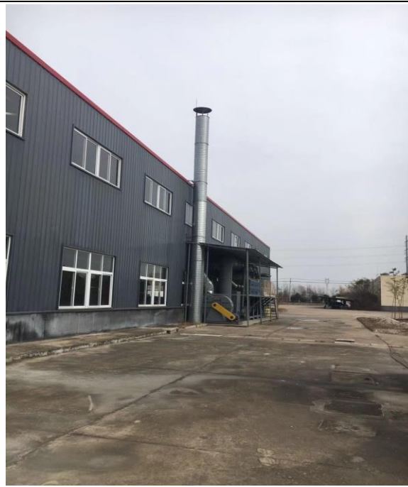
图 3-3 喷漆、丝印、滚黑工序等工序废气排气筒
